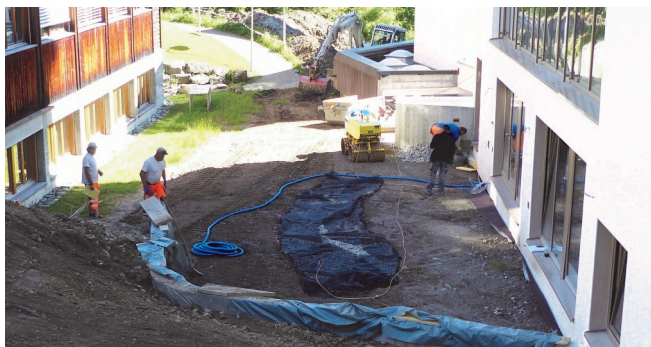
Endspurt der Arbeiten: Es entsteht eine Garten- anlage mit Weiher und Rundwegen.
